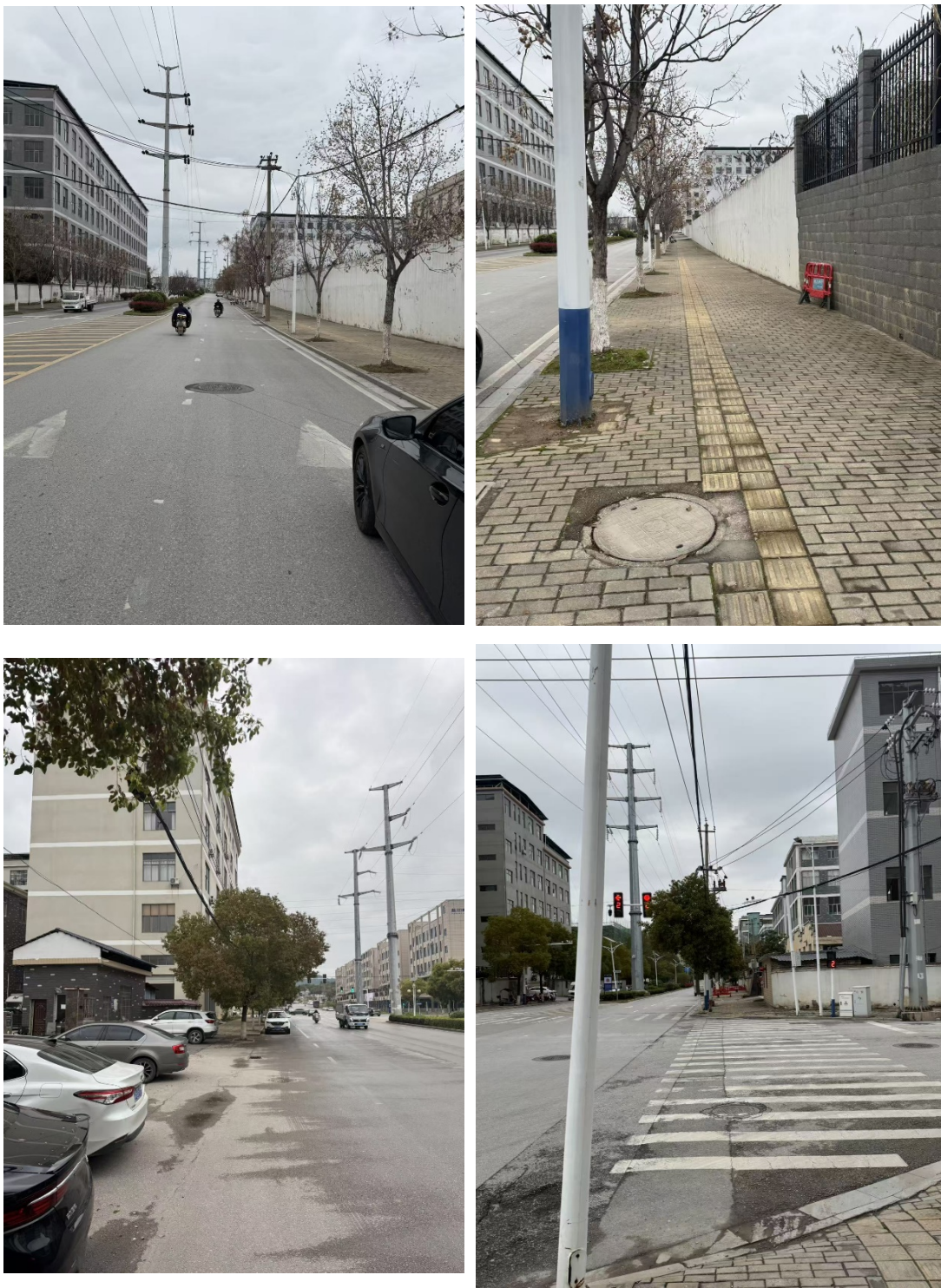
图 3.34 通江路的弱电管沟
