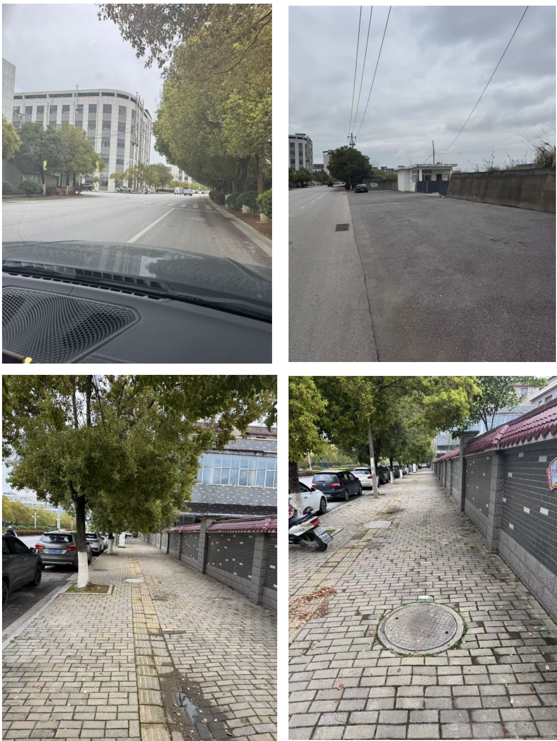
图 3.35 白玉路的弱电管沟
