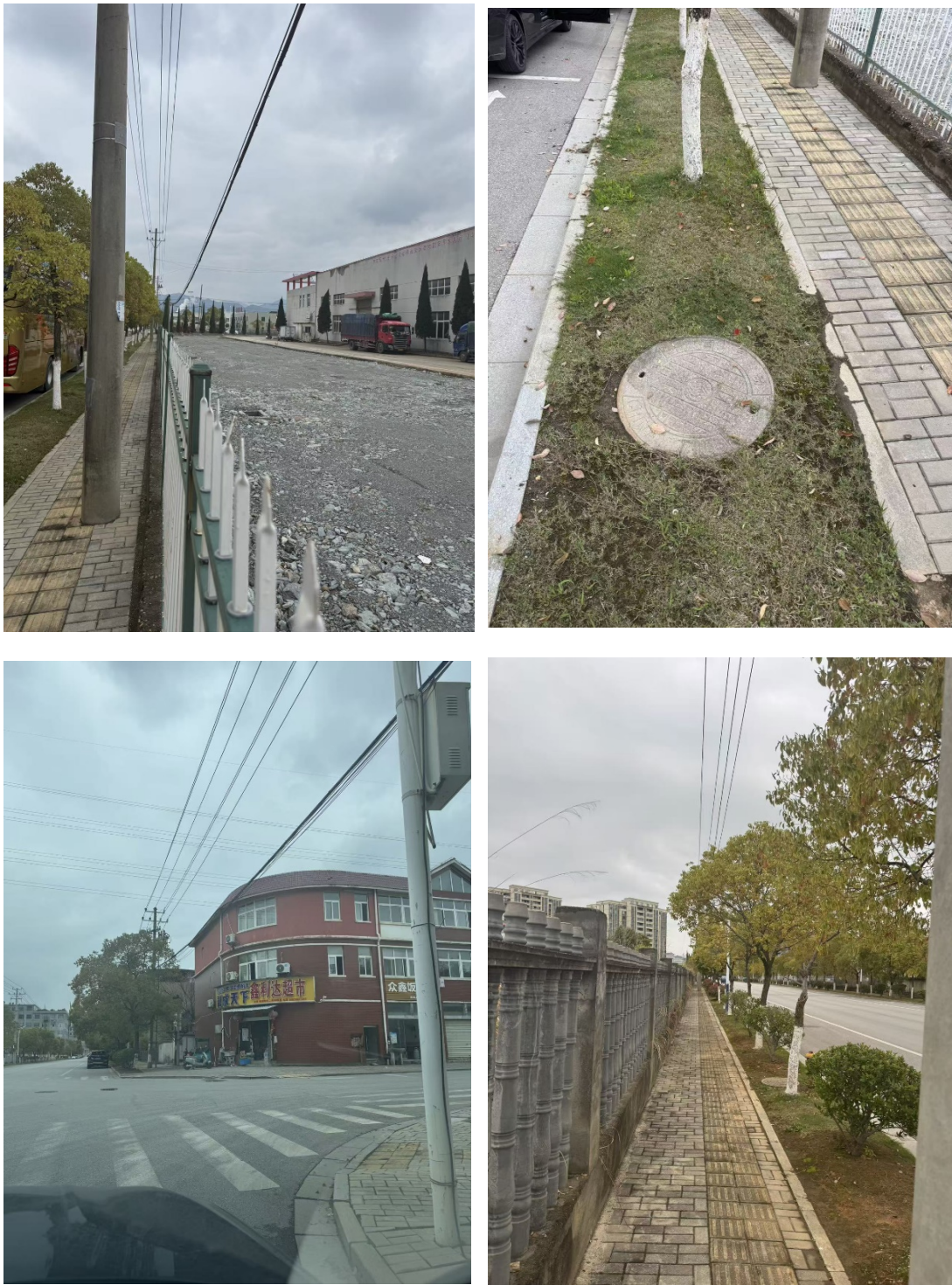
图 3.33 合盛路的弱电管沟
