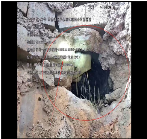
图 3.44 井室破裂
